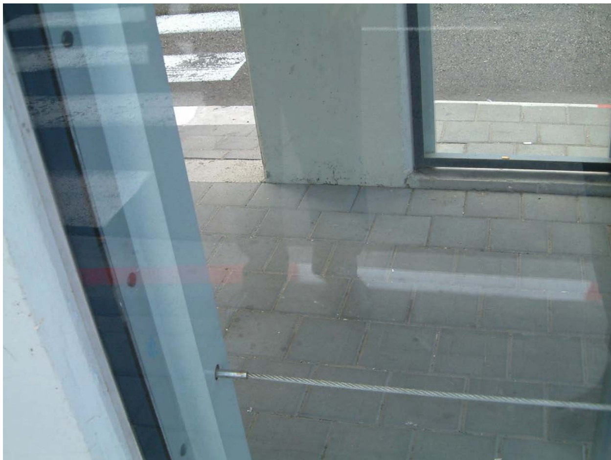
上：爆発のエネルギー（爆風）を吸収できる素材でラミネートされたガラス
