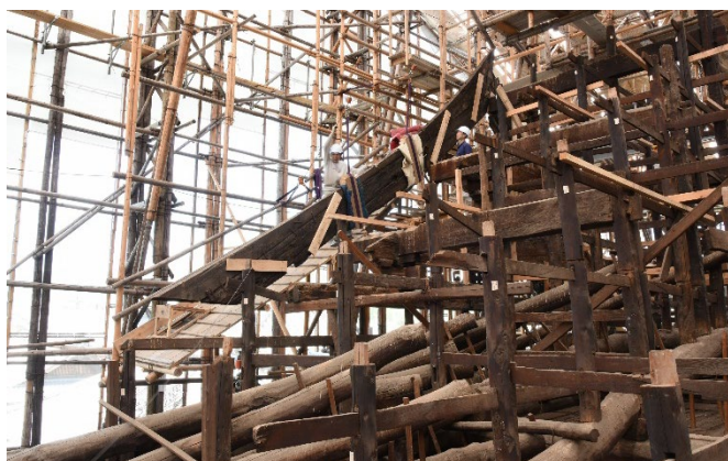
本隆寺 本堂解体修理
